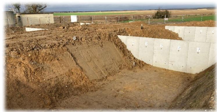
STEP-chantier «traitement file boue»
