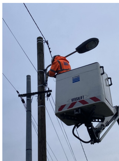
Changement de la lampe rue de la Procession
